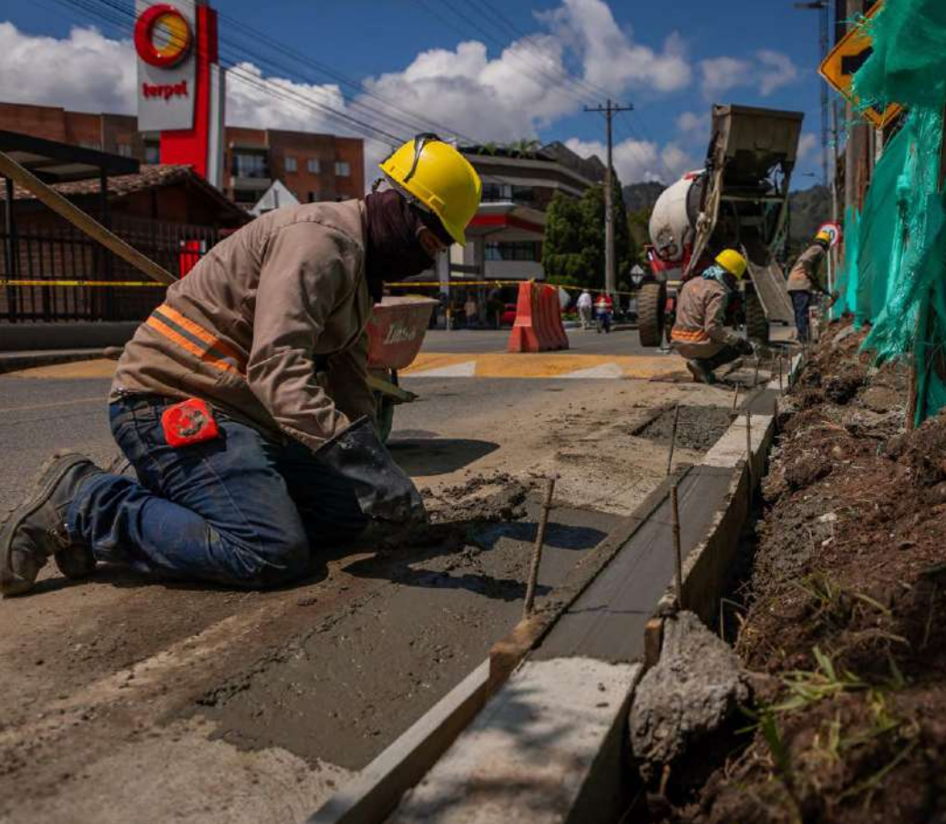
La Alcaldía puso en marcha diferentes proyectos de inversión en Placa Huella y pavimentación de al menos 5.7 km de vías terciarias.
