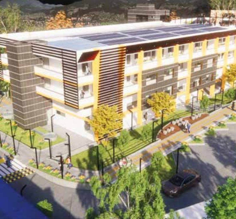
Modelo del Campus de Inteligencia Artificial e Ingenierías de la Universidad de Caldas.
